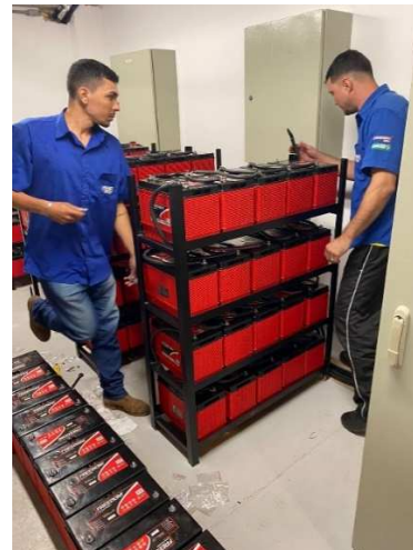
Figura 12) Substituição das baterias do nobreak central dos blocos A e C.
