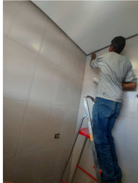
Figura 6) Gabinete do Secretário de Controle Externo pós-obra.
