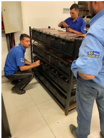
Figura 11) Substituição das baterias do nobreak central do bloco B.
