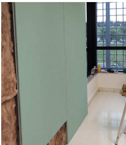
Figura 3) Parede em dry-wall com revestimento termoacústico.
