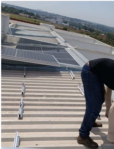
Figura 1) Fixação de placas fotovoltaicas de última geração no telhado do 3 pavimento do edifício-sede (mirante).
