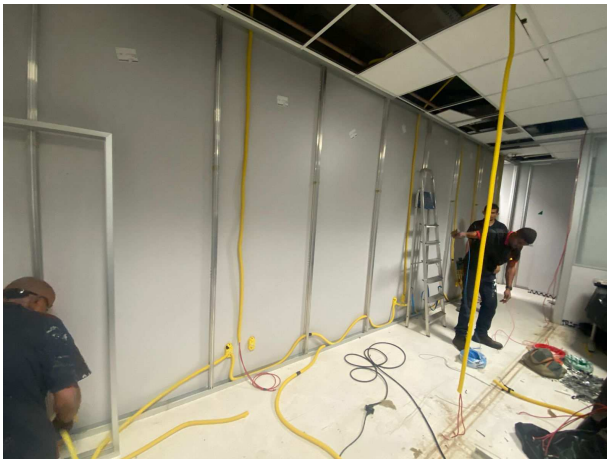
Figura 7) Reforma completa de instalações devido à alteração do layout das divisórias.
